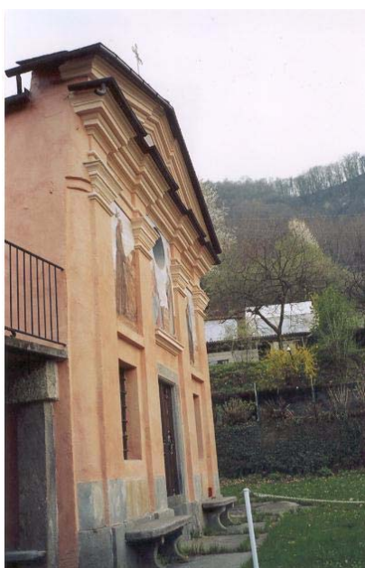
Negativo fotografico n°29 - Scorcio fronte principale
