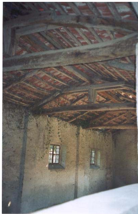
Negativo fotografico n° 06 - Orditura copertura
