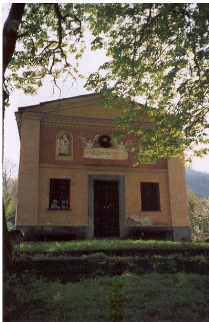
Negativo fotografico n° 07 - Fronte principale
