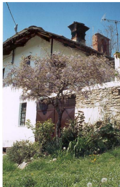
Negativo fotografico n°26 - Particolare fronte principale
