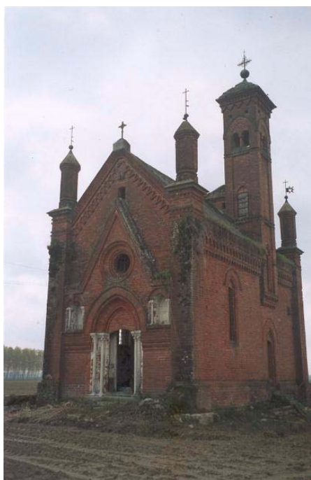
Negativo fotografico n° 17- Scorcio fronte principale
