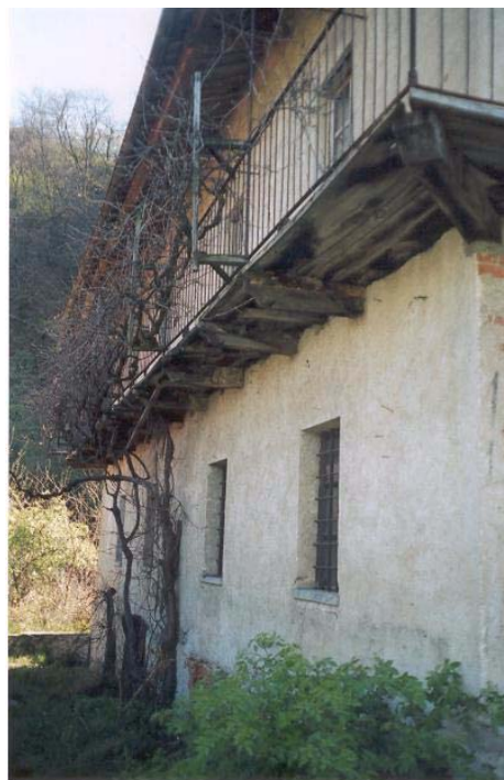
Negativo fotografico n° 01 - Ballatoio
