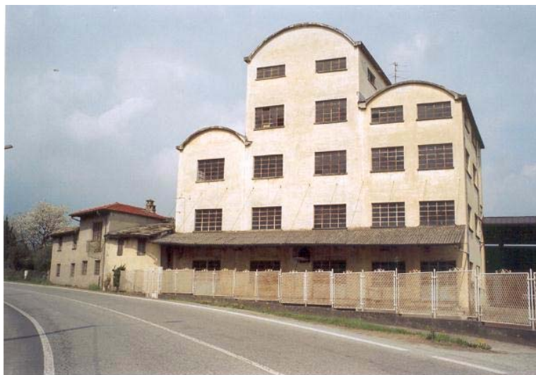
Negativo fotografico n° 09 - Fronte principale
