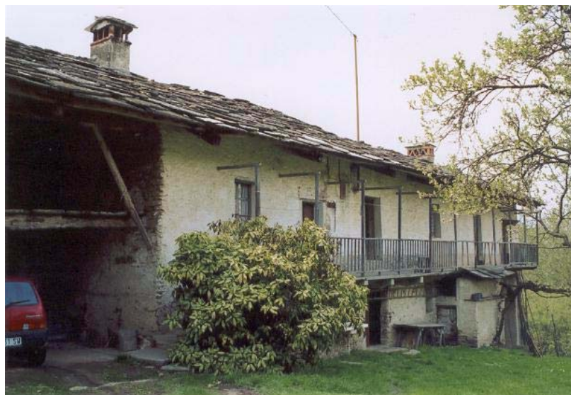
Negativo fotografico n° 31 - Fronte principale
