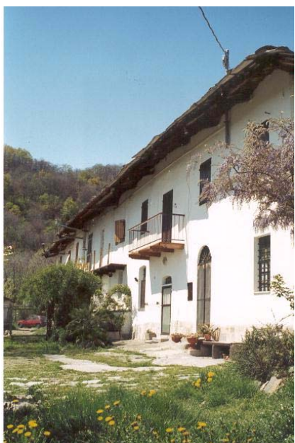
Negativo fotografico n°27 - Scorcio fronte principale
