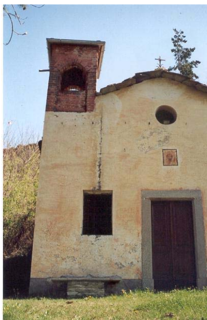
Negativo fotografico n° 14 - Particolare fronte principale
