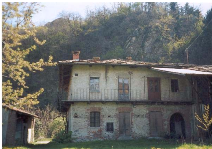
Negativo fotografico n° 02 - Fronte principale
