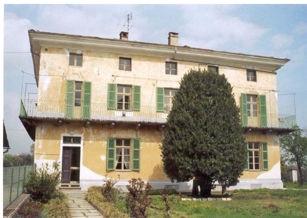
Negativo fotografico n°15 - Fronte principale
