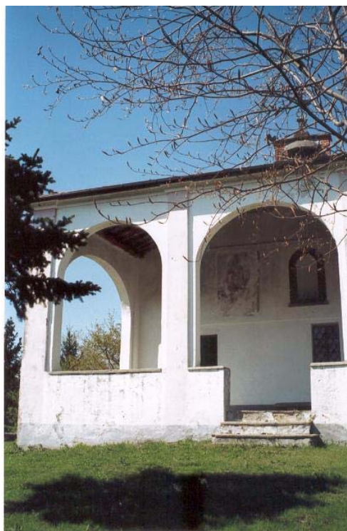
Negativo fotografico n° 30 - Particolare fronte principale
