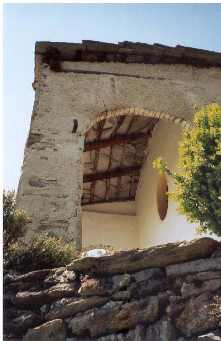
Negativo fotografico n° 22 - Particolare del portico
